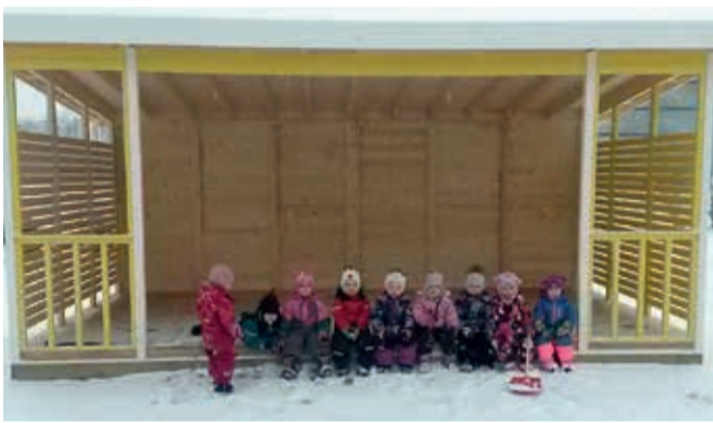
Olustvere lasteaia Piilu pere tunneb suurt rõõmu varjualuse valmimise üle. Täname projektis osalenud häid inimesi ja abikäe ulatanud ettevõtteid. Foto: Tiina Alles
